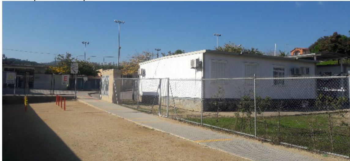
Talús existent entre la parcel·la i la carretera. Mòduls prefabricats provisionals i pati.
