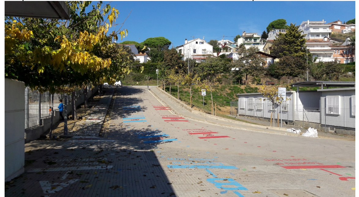
Rampa actual de connexió amb la carretera. A la dreta mòduls prefabricats a desmuntar.
