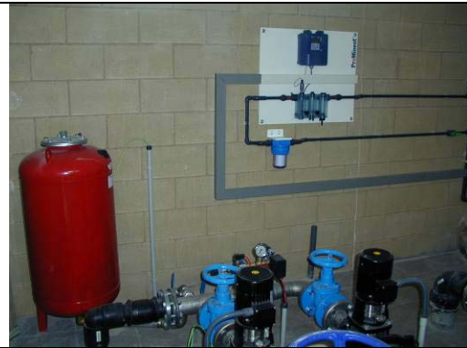
Analitzador en continu i sistema antiarriet del grup de pressió
