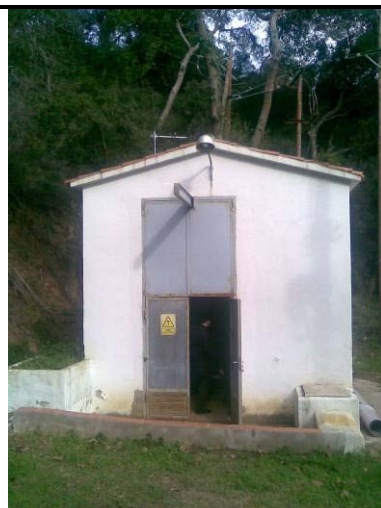
Caseta de l'estació d'elevació Sot d'en More
