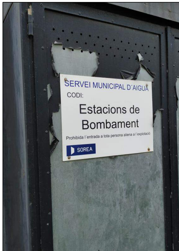
Figura 5: Placa de l'EDAR.
