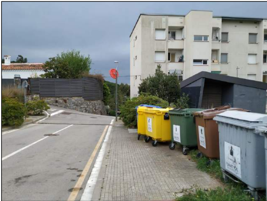
Figura 4: Avinguda Roques Blanques per on passa el tub d'impulsió fins a l'EDAR.
