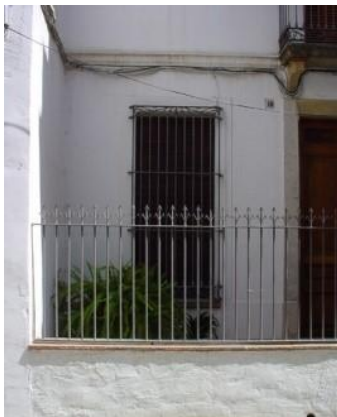
Detall de la tanca exterior
