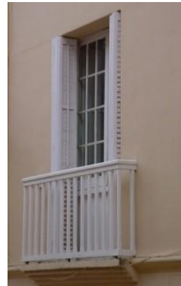
Detall balcó façana principal
