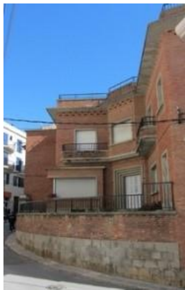
Detall de la tanca exterior
