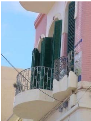
Detall balcó façana principal
