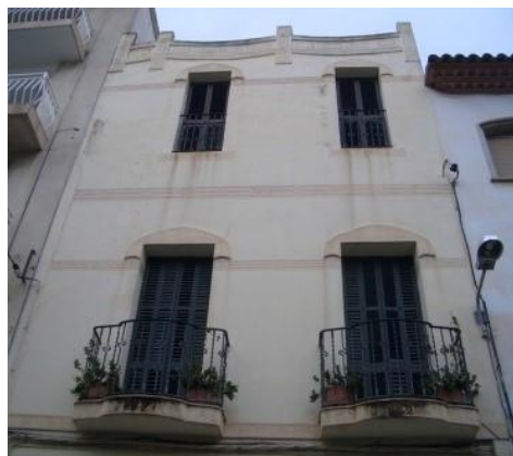
Detall balcó façana principal
