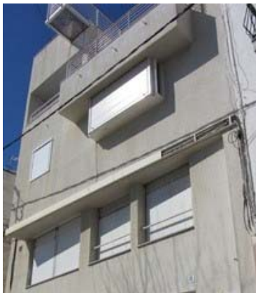
Detall de la tanca exterior
