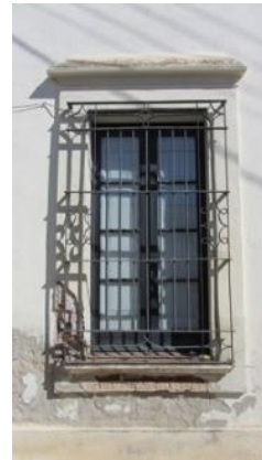
Detall obertura en façana principal
