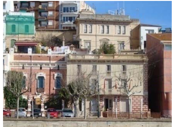
Vista general de la façana principal
