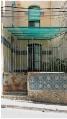
Vista de la tanca exterior
