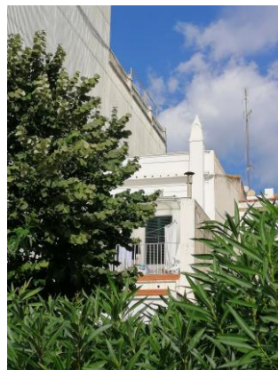
Vista façana sud-est
