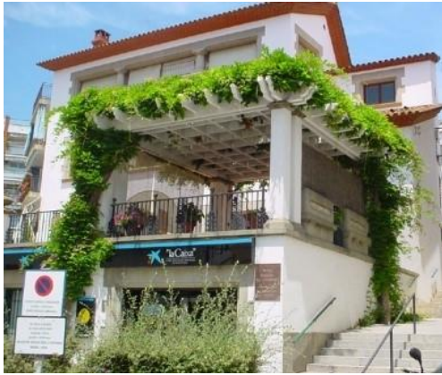
Vista de la façana principal
