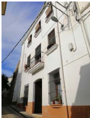
Vista façana inferior per C/ Abat Deàs
