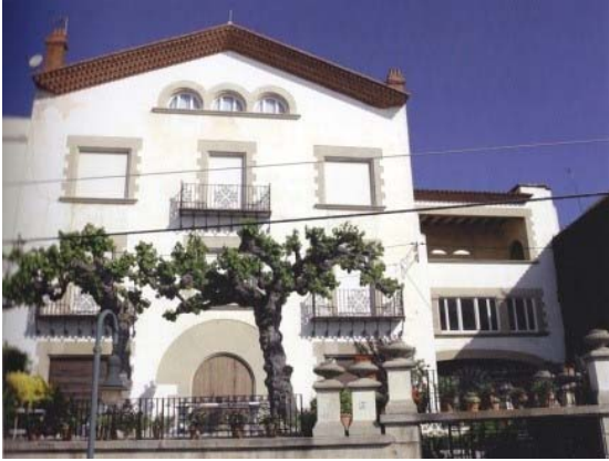
Vista de la façana general
