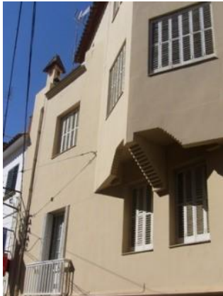
Vista de la façana general
