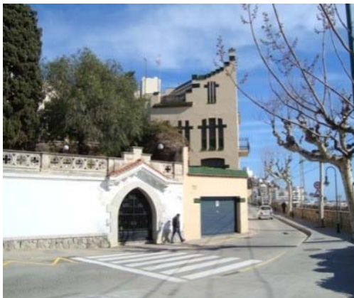
Detall de la tanca exterior
