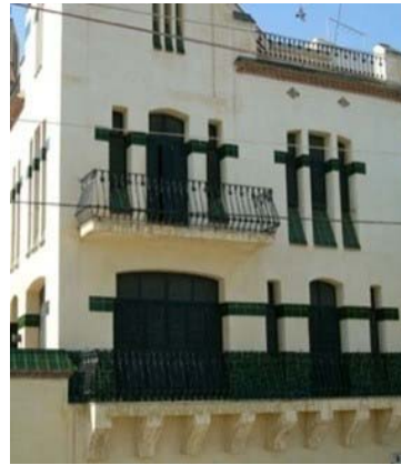
Detall balcó façana principal
