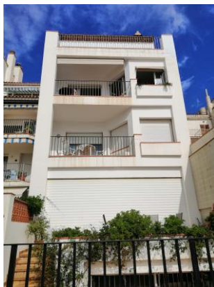
Vista façana sud-est
