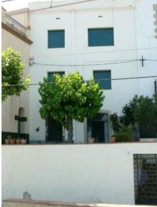
Vista de la façana general
