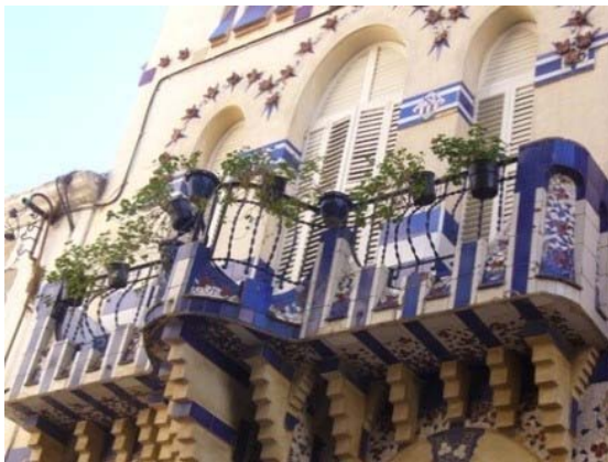
Detall balcó façana principal
