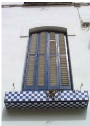
Detall de l'obertura de la façana
