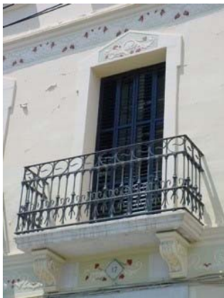
Detall balcó façana principal
