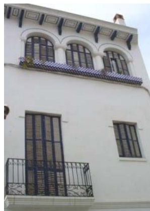
Detall balcó façana principal
