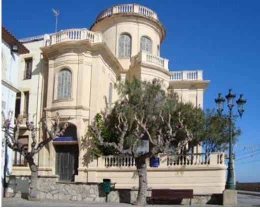
Vista de la façana general
