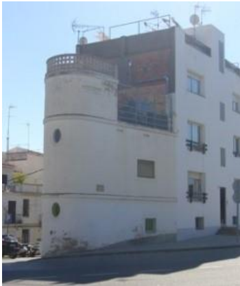
Vista de la façana de ponent
