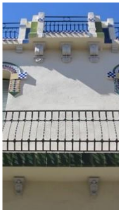
Detall balcó façana principal
