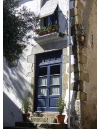
Detall del portal d'accés principal
