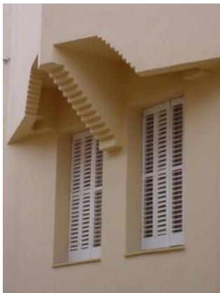
Detall de les obertures de la façana principal
