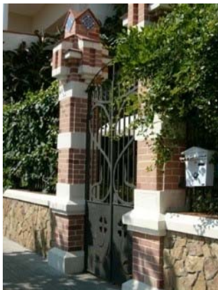
Detall de la tanca i accés exterior
