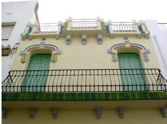
Detall balcó façana principal
