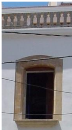
Detall d'una de les obertures de la planta pis
