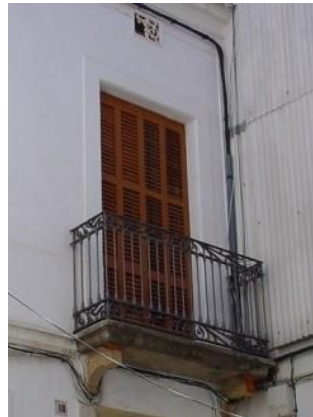
Detall balcó façana principal
