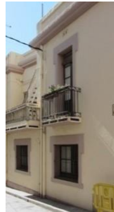
Detall balcó façana principal
