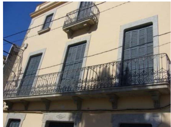
Detall balcó façana principal
