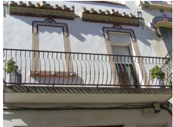
Detall balcó façana principal
