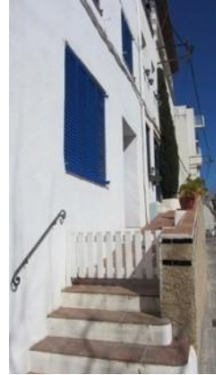
Vista de l'accés elevat a l'edifici
