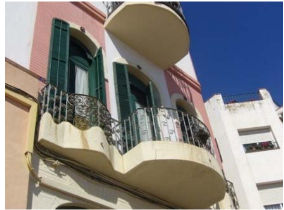
Detall balcó façana principal
