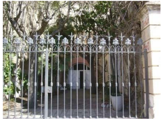
Detall de la tanca exterior
