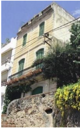
Vista de la façana general
