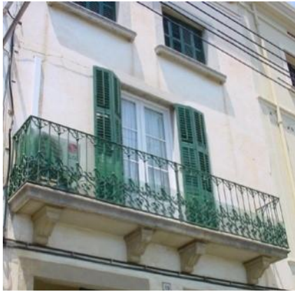
Detall balcó façana principal
