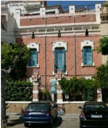
Vista de la façana general
