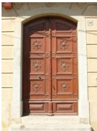
Detall del portal d'accés principal
