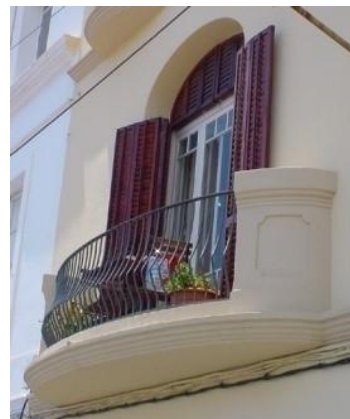
Detall balcó façana principal
