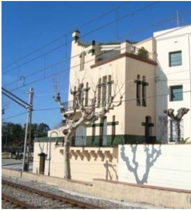
Vista de la façana general
