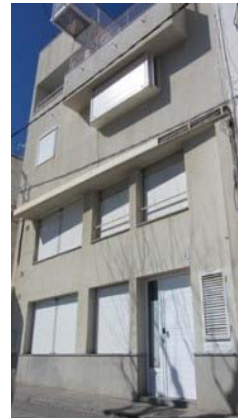
Detall balcó façana principal
