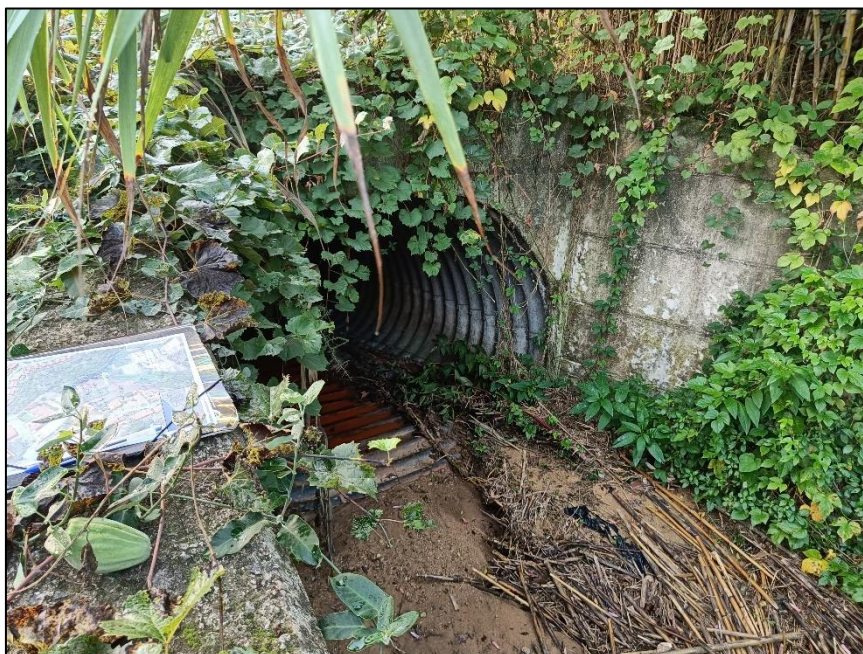
Figura 11. Entrada del soterrament del Torrent de l'Arrosser (ARRO_03).
