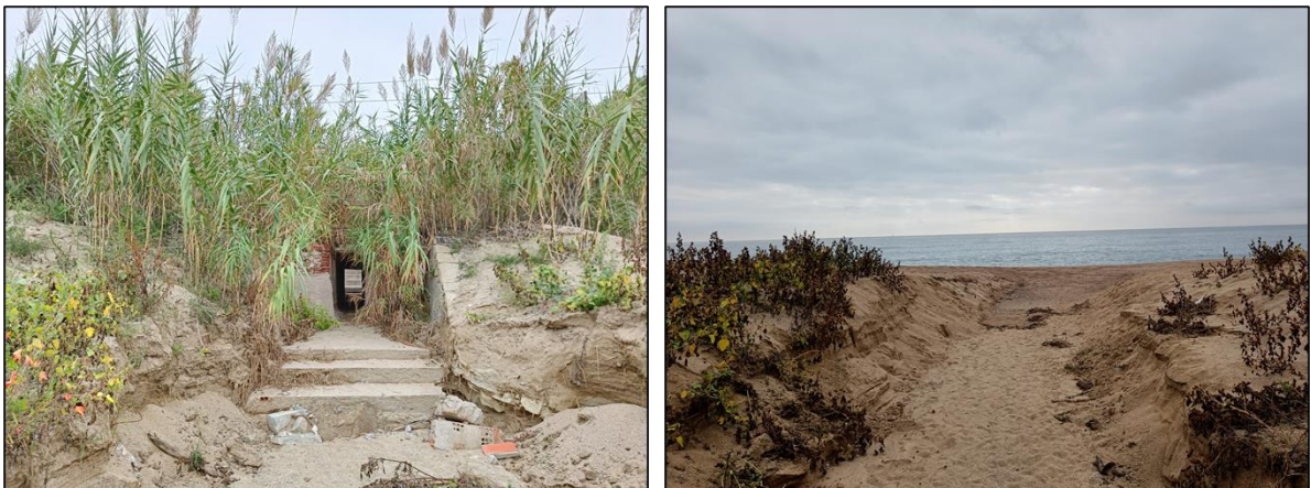
Figura 9. Obra de drenatge sota el ferrocarril (TOR_02) i desembocadura al mar.
