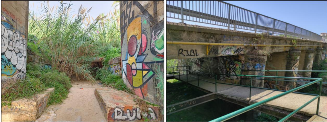
Figura 14. Antic pont (MOR_00) i pont de trànsit rodat N-II (MOR_02)
