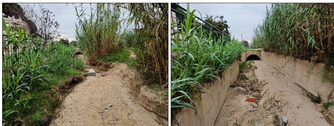
Figura 4. Punt baix al marge dret del torrent i obra de drenatge (SEG_01)
