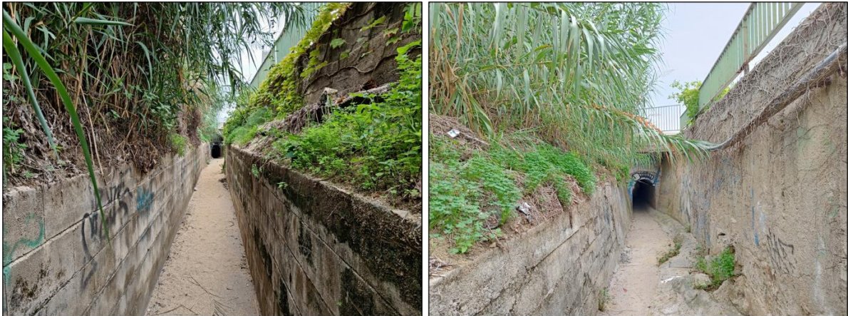
Figura 8. Llera del curs innominat i obra de drenatge sota la N-II (TOR_01)
