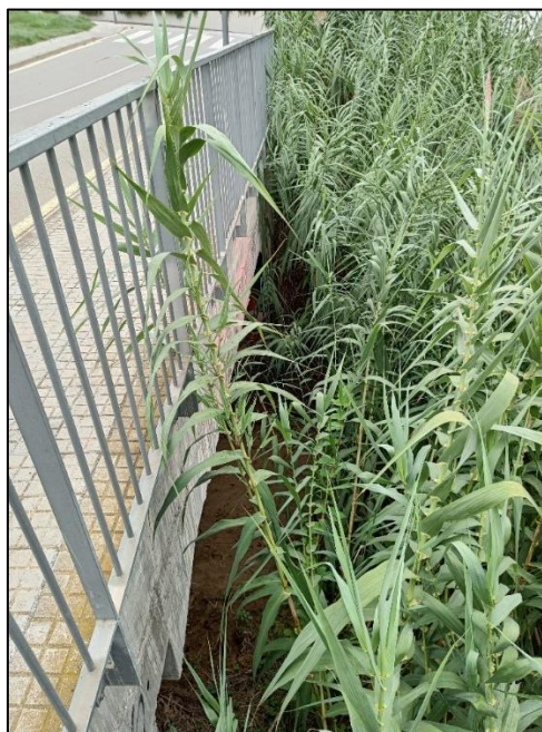
Figura 13. Pont de trànsit rodat (MOR_01) vist des d'aigua avall.
