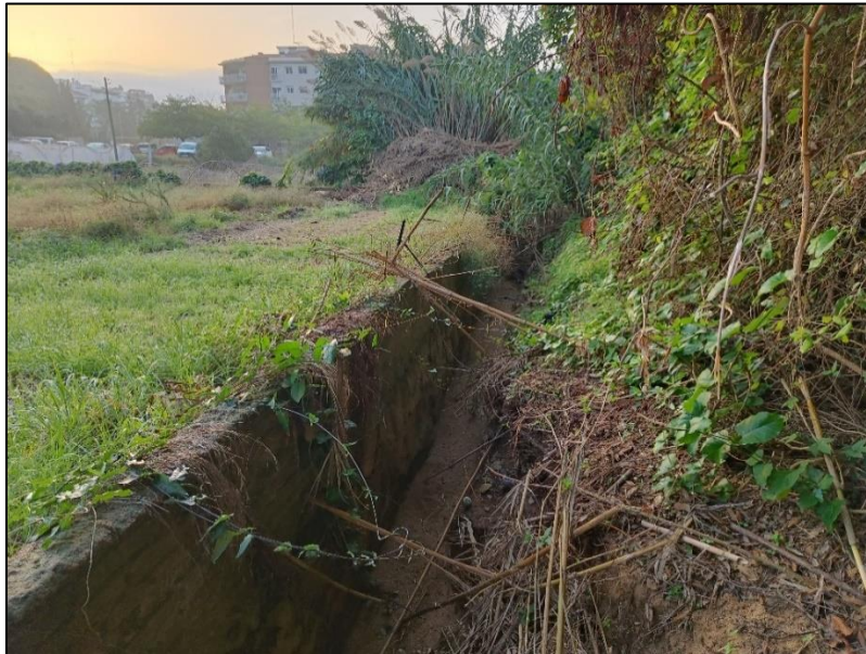
Figura 10. Mur al marge esquerre del torrent de l'Arrosser.
