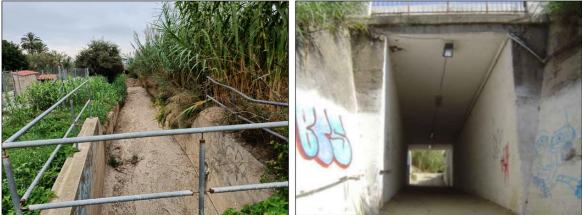
Figura 5. Sortida de la obra de drenatge SEG_01 i vista des d'aigua avall del pont de trànsit rodat de la carretera N-II (SEG_02)
