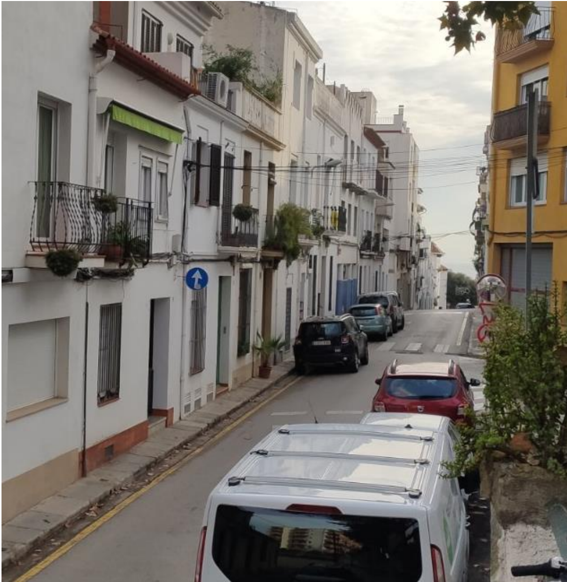
Secció de carrer intern del municipi. Voreres inaccessibles i vehicles estacionats fora de plaça
