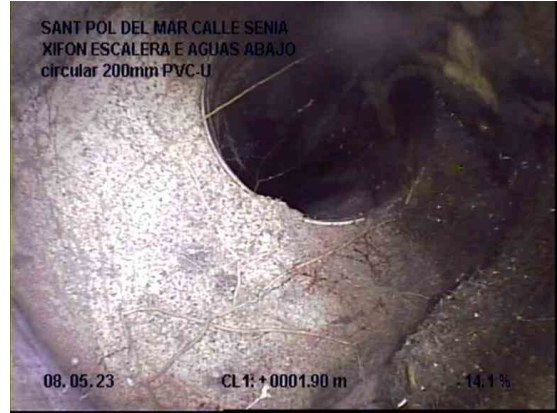
2, 00:02:56, 1.90m Nudo de final, registro,, AGUAS ABAJO / ARQUETA 1
