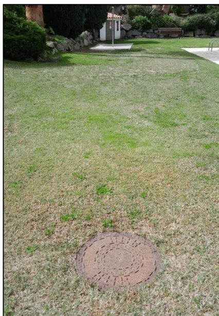
Figura 14. Pou que actualment es connecta a la nova xarxa
