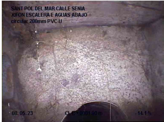
3, 00:02:56, 1.90m Nudo de final, registro,, AGUAS ABAJO / ARQUETA 1
