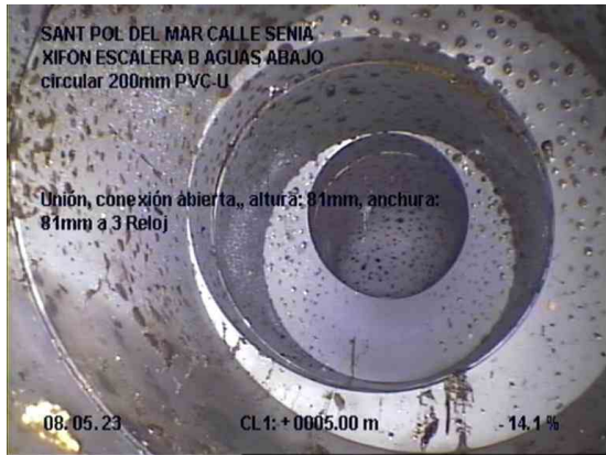
1, 00:01:32, 5.00m Unión, conexión abierta,, altura: 81mm, anchura: 81mm a 3 Reloj
