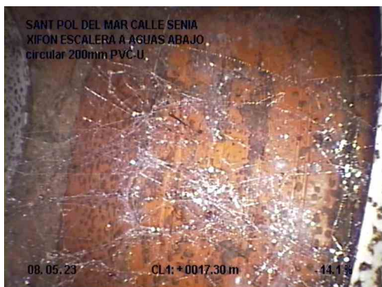
5, 00:05:58, 17.30m Nudo de final, registro,, AGUAS ABAJO / ARQUETA OCULTA
