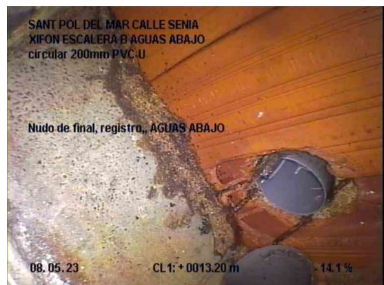
6, 00:08:44, 13.20m Nudo de final, registro,, AGUAS ABAJO / ARQUETA OCULTA
