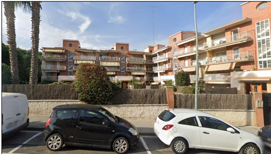
Figura 17. Façana exterior de la zona d'actuació.
