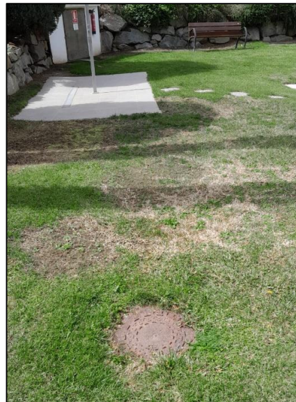
Figura 13. Pou que actualment es connecta al torrent arrosar
