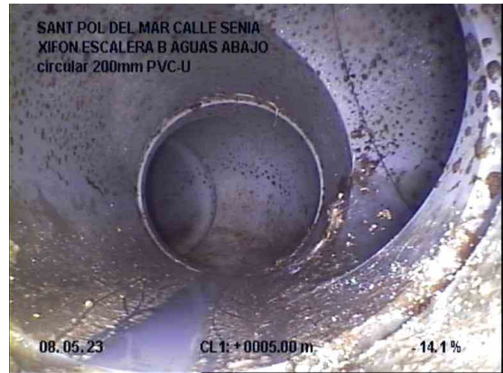
2, 00:01:32, 5.00m Unión, conexión abierta,, altura: 81mm, anchura: 81mm a 3 Reloj
