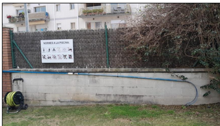
Figura 15. Mur entre casetes, secció del mur per on es connecta el tub amb el pou de l'exterior
