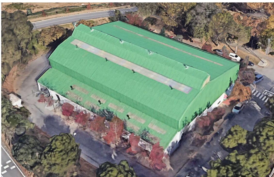
Imagen 1. Foto aérea de la cubierta a analizar
