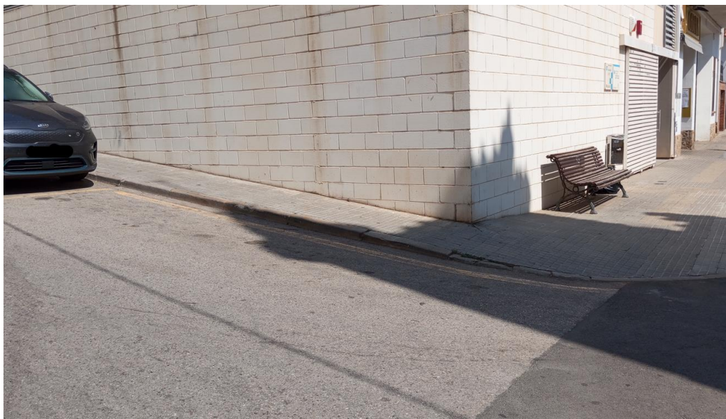
Figura 7. Imatge de la localització de l'arqueta amb vàlvula reguladora amb control i monitorat IoT, del C. Antoni Sauleda i Paulis.
