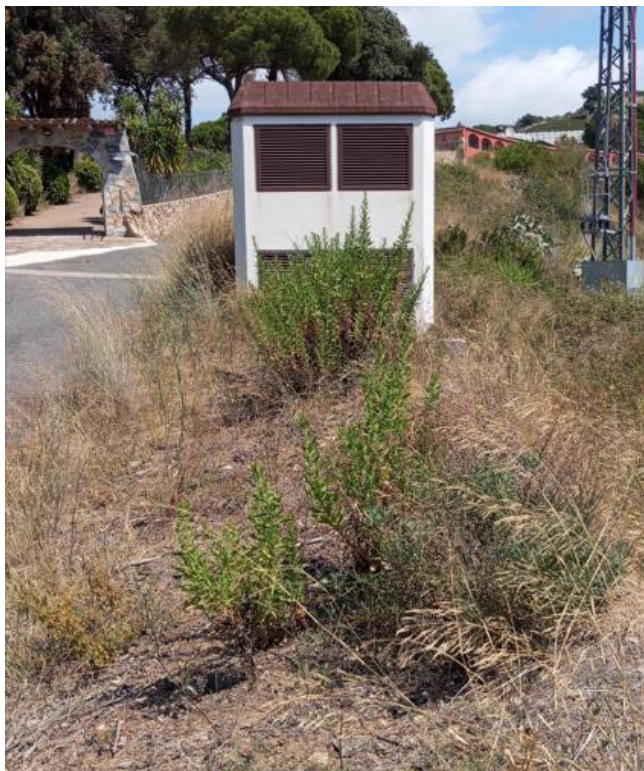
Figura 1 i 2. Imatges de la localització de l'arqueta amb vàlvula reguladora amb control i monitoratge IoT, del polígon industrial.
