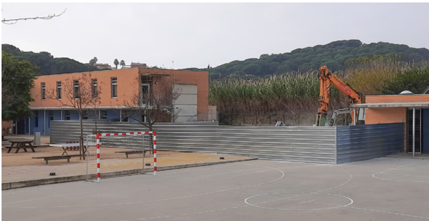
Obres de la primera fase d'ampliació (novembre 2020)
