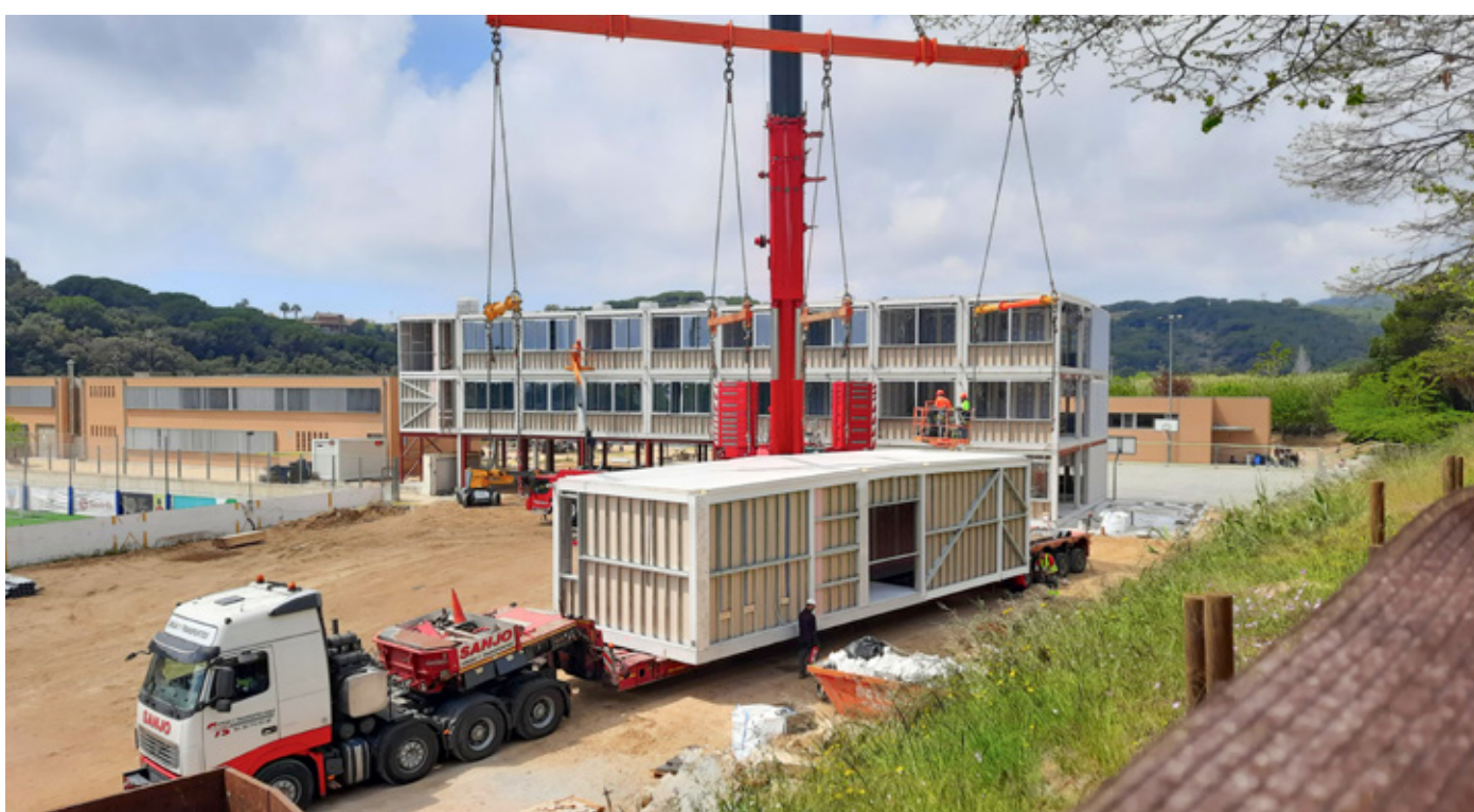
Obres de la segona fase d'ampliació (gener 2024)
