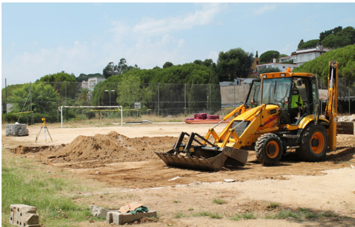
Les aules modulars es van instal·lar a les pistes esportives del Parc del Litoral (agost 2015)
