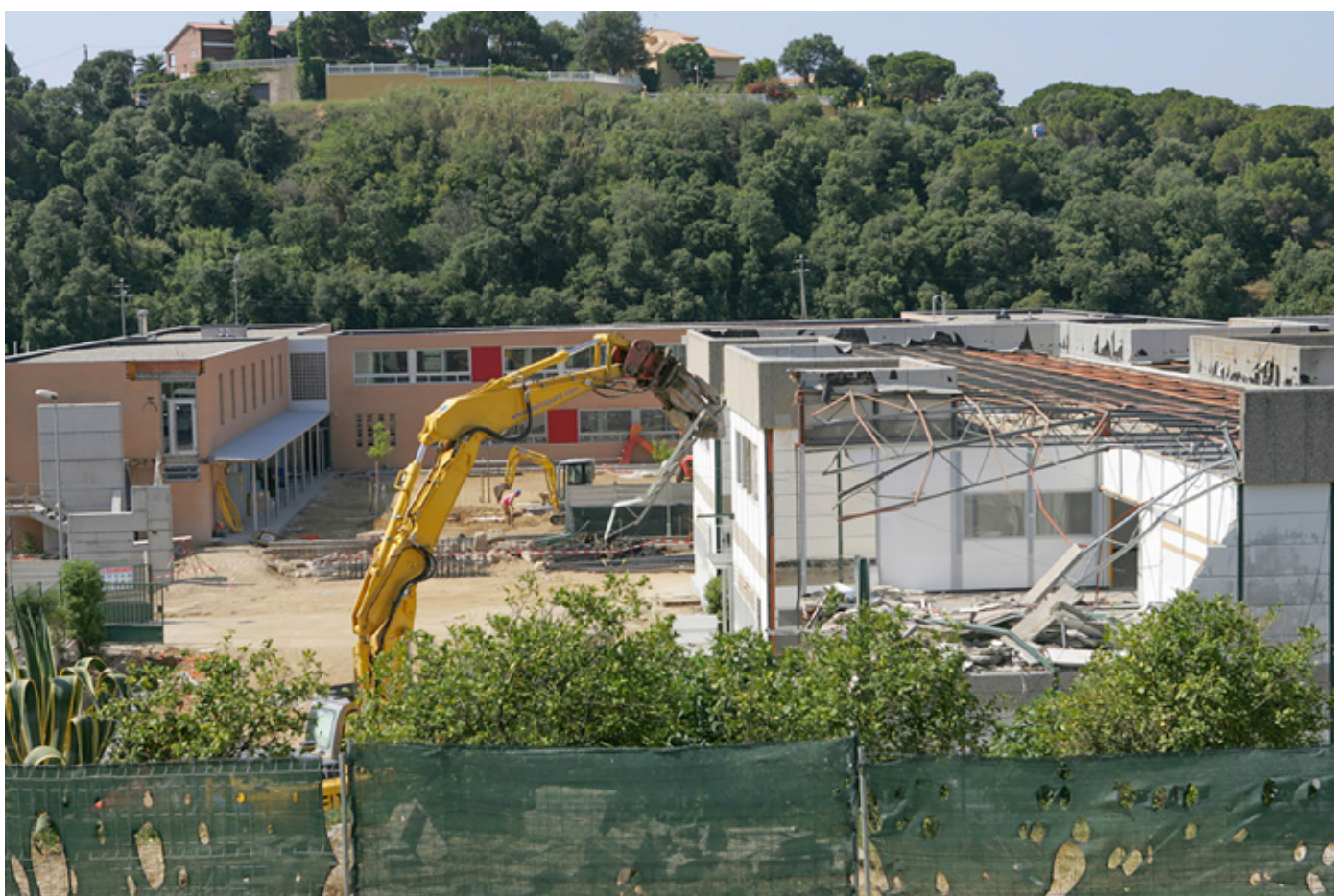
Enderroc de la construcció original de l'Escola Sant Pau. Al fons s'hi pot veure el nou edifici. (2008)
